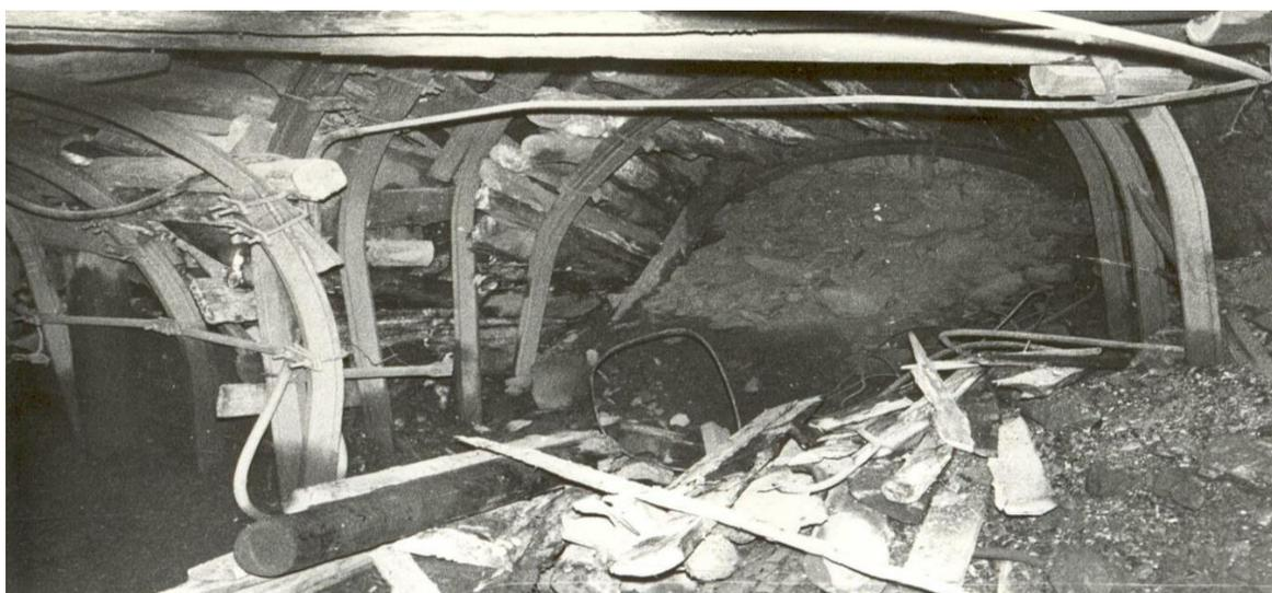
Рис. 2. Разрушение подготовительной выработки на глубине 350 м. Факторов (Кадамжай)
