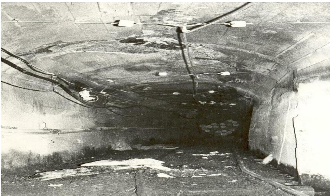
Рис. 1. Разрушение квершлага нагор. 870 м рудника Кадамжай.
